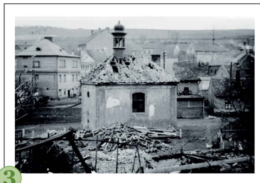
č. 3 Stav po náletu 14. 2. 1945. Radlice spolu s Farkáněm byly zasaženy bombardováním jako první části Prahy.
